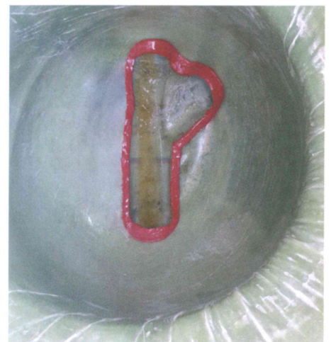
Vergleich vorher – nachher: Der Schacht wird mit einem UV-Liner bis samt Berme ausgekleidet und mit einer UVA-Anlage ausgehärtet. Danach erfolgt die Sanierung des Gerinnes mit einem Gerinneliner.
