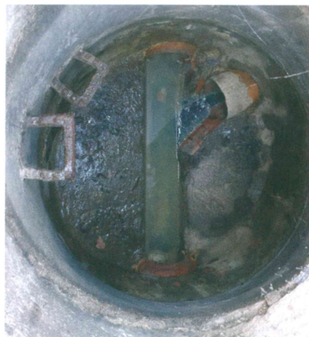
Vergleich vorher – nachher: Der Schacht wird mit einem UV-Liner bis samt Berme ausgekleidet und mit einer UVA-Anlage ausgehärtet. Danach erfolgt die Sanierung des Gerinnes mit einem Gerinneliner.
