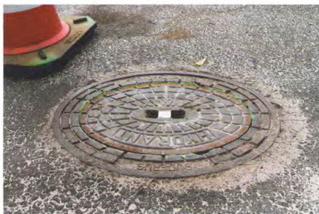
3: ... so dass der Verkehr nach der Sanierung wieder ungestört gleiten kann
