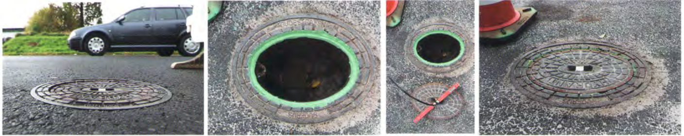
Hydrantenkappe vorher • Hydrantenkappe mit Flüsterkappe • Hydrantenkappe mit Deckel und Flüsterkappe • Hydrantenkappe nachher (v. l. n. r.)
