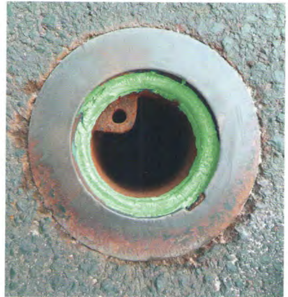
Nach der Reinigung der geöffneten Kappe inklusive Deckel wird das dauerelastische Epoxidharz auf die Auflagefläche für den Hydranten- bzw. Schieberkappendeckel aufgetragen.
