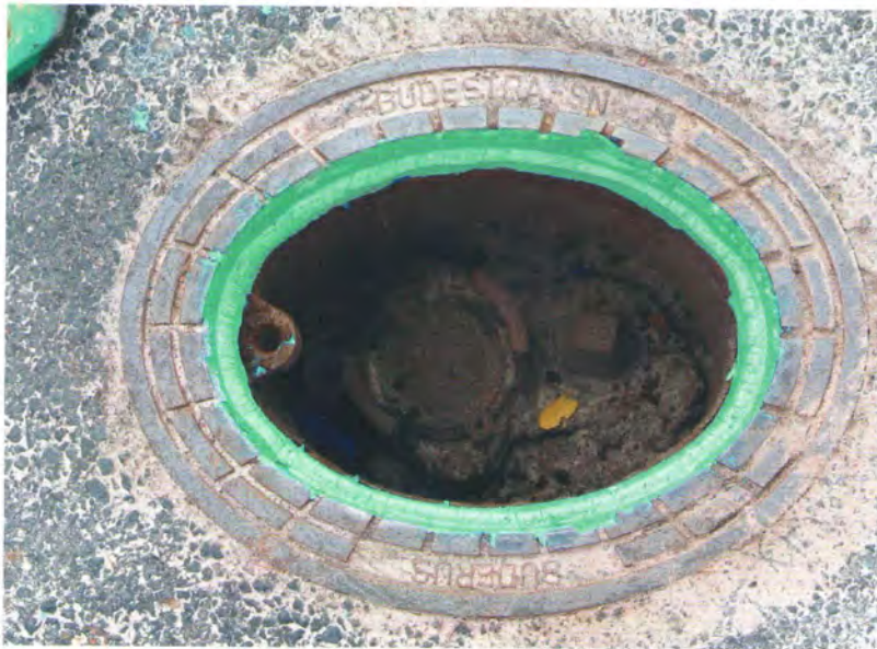
Nach der Reinigung der geöffneten Kappe inklusive Deckel wird das dauerelastische Epoxidharz auf die Auflagefläche für den Hydranten- bzw. Schieberkappendeckel aufgetragen.
