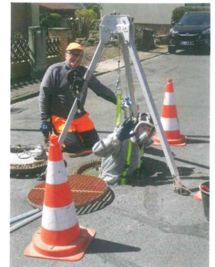
**Bild 2:** Schachtsanierung mit „Schacht Completed“
