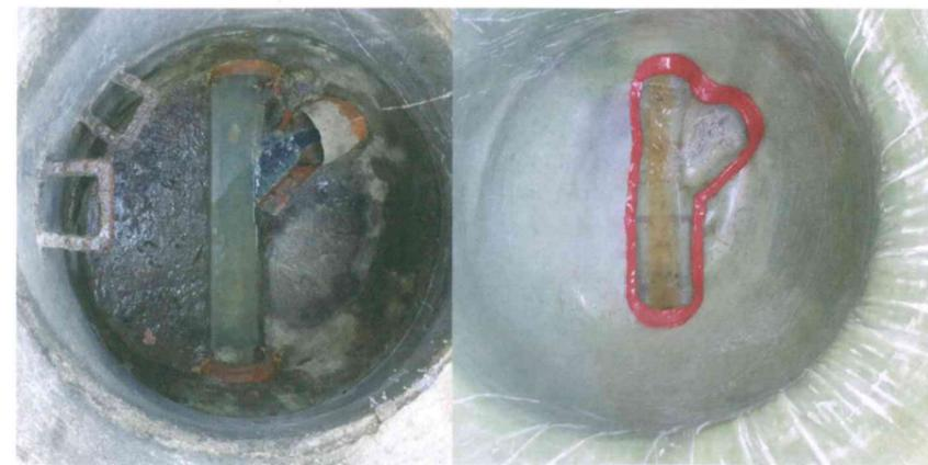
**Bild 1:** Vergleich vorher - nachher: Der Schacht wird samt Berme mit einem UV-Liner ausgekleidet und mit einer UV-Anlage ausgehärtet. Danach erfolgt die Sanierung des Gerinnes mit einem Gerinneliner
