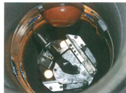
**Bild 1:** Das neue Reaktionsharz Konudur Robopox 10 fast im Einsatz mit Robotertechnik im nicht begehrbaren Kanal
